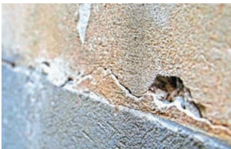
Ustrezna statična sanacija pomeni najprej natančen pregled konstrukcije in oceno poškodb, na podlagi tega pa izdelavo načrta statične sanacije. / Foto: Gorazd Kavčič
