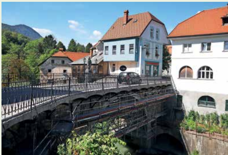
Restavratorsko-konservatorska dela na Kamnitem mostu bodo zaključena v oktobru. / Foto: Gorazd Kavčič
