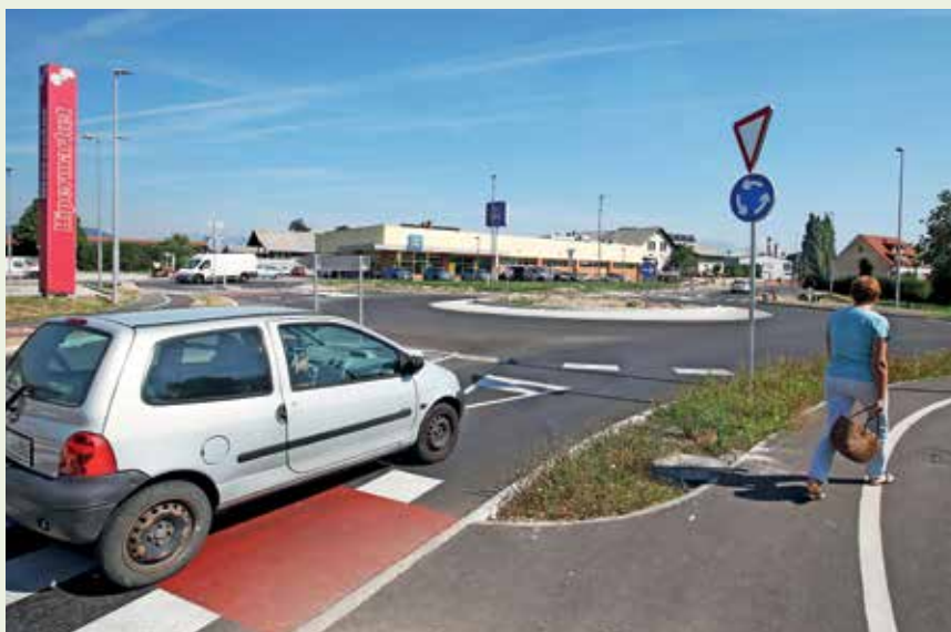
Novo krožišče na Kidričevi cesti je veliko bolj varno in pregledno. / Foto: Gorazd Kavčič
